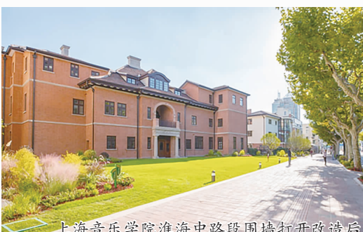
上海音乐学院淮海中路段围墙打开改造后
