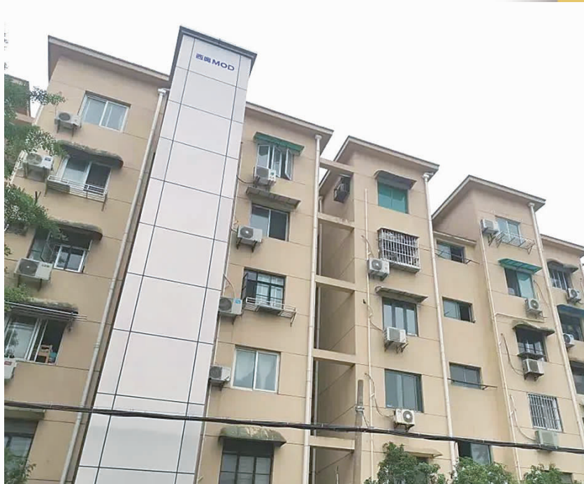
整体吊装完成
