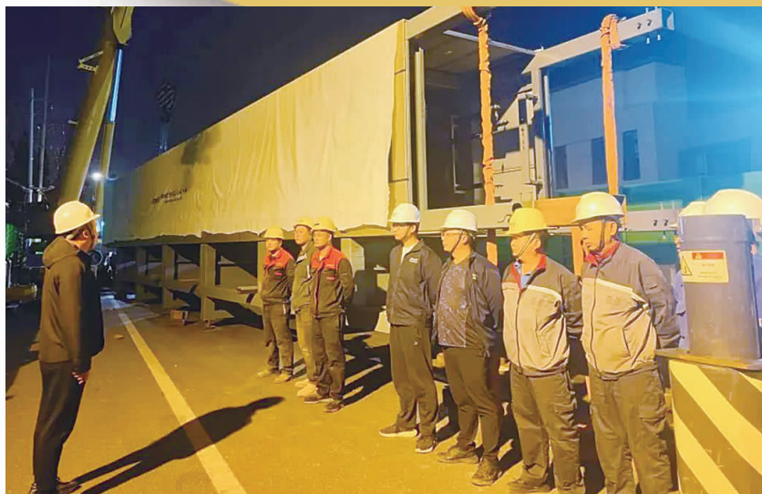
一段式整体装配电梯运送到现场
