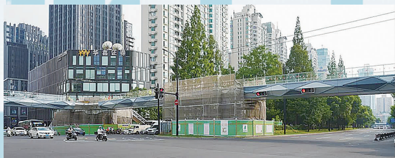
施工中的肇嘉浜路宛平路天桥
