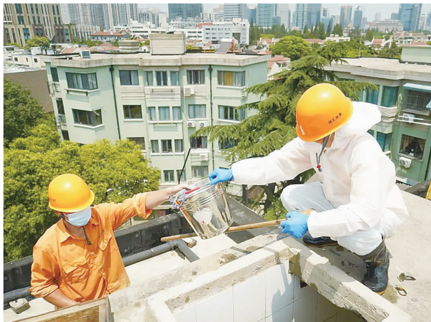
/ 清洗楼顶水箱
