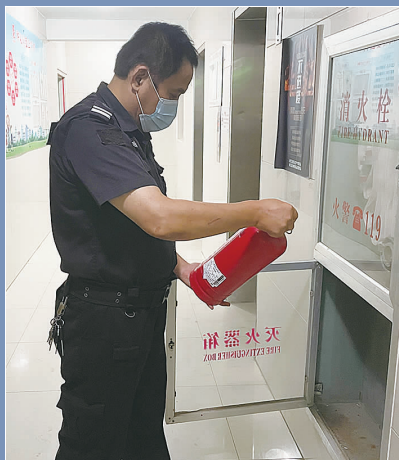
检查消防设施
