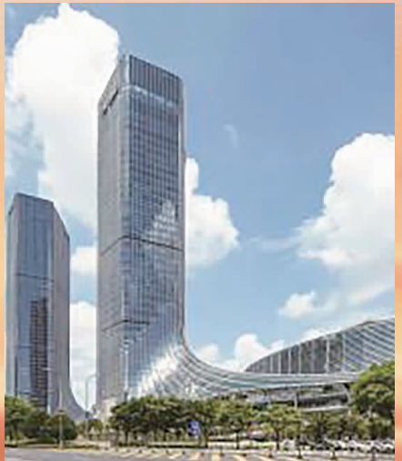
西岸智塔(AI Tower)
