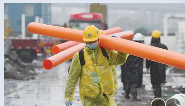
白猫方舱医院施工
