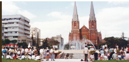
修缮前的徐家汇天主教堂广场
